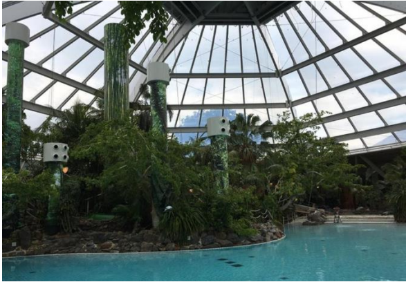
Center Parcs renovatie zwemkoepel Ø 62 meter
